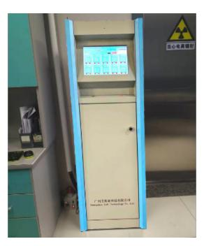
核医学放射性废液处理设备:液体废物:液体废物采用建立槽式排放衰变池引,根据液体废物的产生量和核素的半衰期建设衰变池,衰变池的容积应满足废液存放10个半衰期的要求。一般建设三级槽式衰变池,废液首先排入一号池衰变,待一号衰变池排入废液近满时,关闭一号衰变池。同时,开启第二个衰变池,供废液排入使用,以此类推循环。每个衰变池均设有显示放射性废液比活度的检测装置,系统预设定废液安全排放阂值,当达到排放标准时,系统准许排放。经污水处理站外排至环境,确保水环境的辐射水平不受影响。
